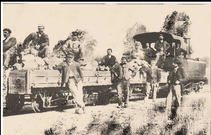
Travaux réseau sud
