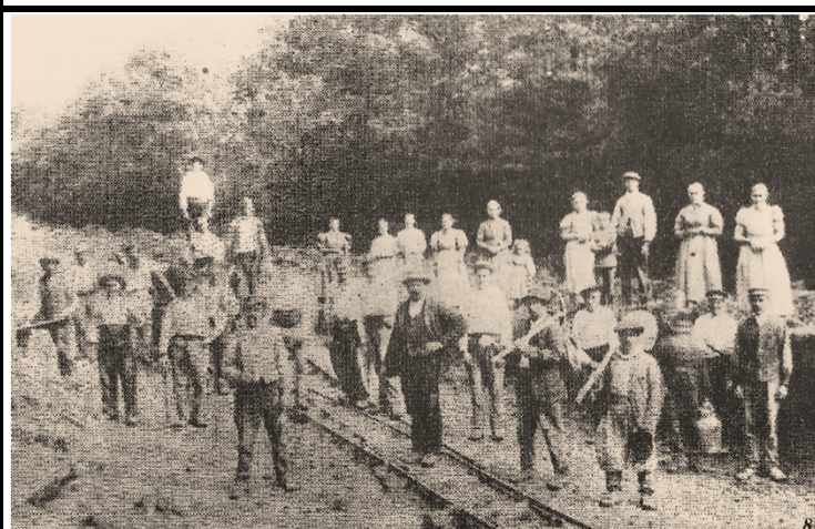
Construction Cassine Sauville
